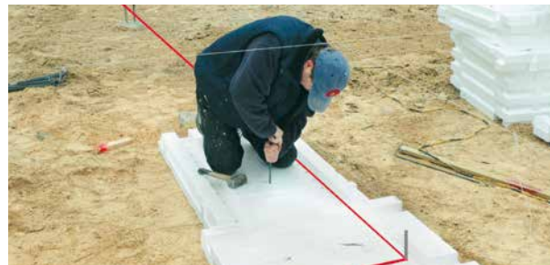
2 De bodemplaat kan dankzij de geïntegreerde voorziening over de vooraf uitgezette metalen piket geplaatst worden. Zo staat de funderingskist direct op de betonmaat uitgelijnd.
