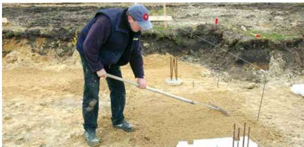
1 Het zandbed zodanig egaliseren en verdichten dat de bodemplaten voldoende ondersteuning krijgen.
