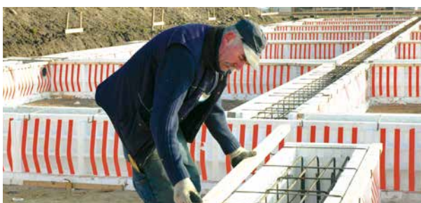
7 Houten ribben (afm. 50 x 70 mm) in bovenbeugels leggen en klampen bij hoeken.
