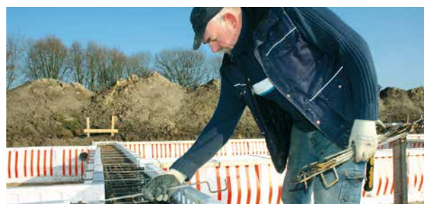
6 Bovenbeugels aanbrengen, ca. 600 mm h.o.h.
