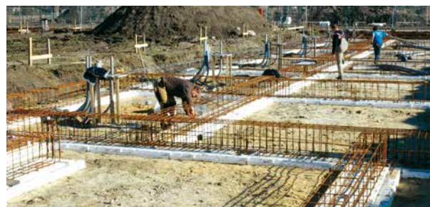
4 Wapening plaatsen en afstandhouders aanbrengen die voldoende betondekking geven en geschikt zijn voor isolatie op zachte ondergrond.
