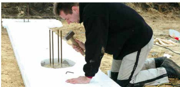
3 Met bodemplaten verbindingen maken tussen de hoeken.
