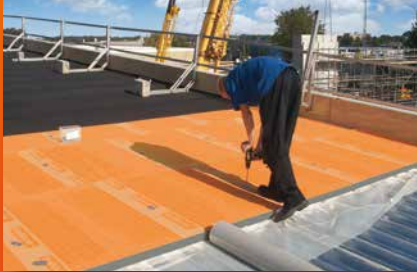
plat dak isolatie
