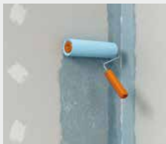
Afb. 18: fermacell Diepgrond aanbrengen op het hele oppervlak
