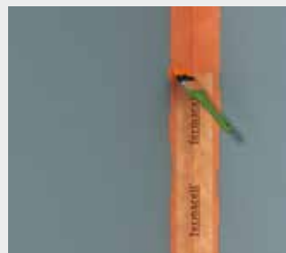
Afb. 19b: ...en meteen afsmeren met Vloeibare folie
