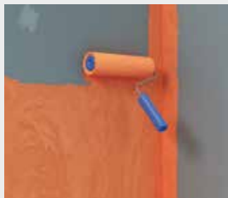
Afb. 23: fermacell Vloeibare folie met de rol 2 x volvlaks aanbrengen (totale dikte > 0,5 mm)
