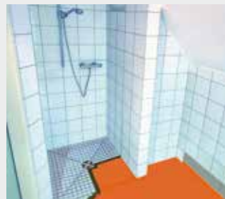
Afb. 25: Bij gipsvezel is vloeibare folie verplicht! Vloeroppervlakken kunnen worden uitgevoerd met fermacell Vloerelementen. Meer informatie vindt u in de brochure "fermacell Vloerelementen - Systeemplossingen voor elke vloer".
