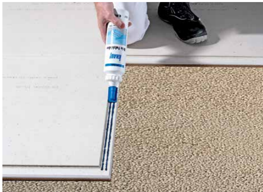
Verlijmen van de verbindingslip met twee rupsen Knauf Overlappingslijm.
