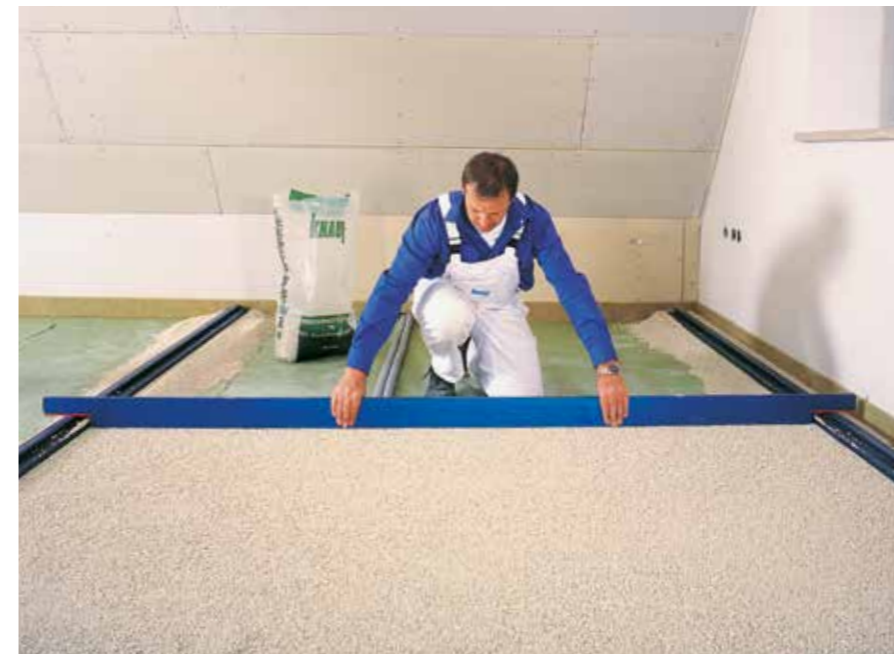
Gebruik van de rijenset.
